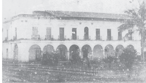
EL PALACIO MUNICIPAL TRAS EL INCENDIO, en 1920. Nótese la diferencia en el techo, la teja.
