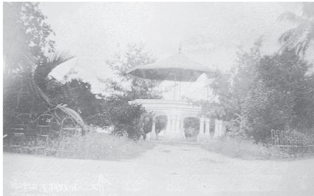
En 1932, el parque estaba boscoso y el techo antiguo del segundo piso del kiosco era sostenido sólo por unos tubos.
