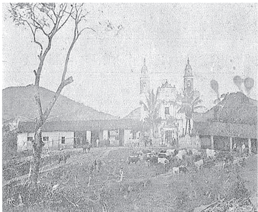
Fachada de la hacienda El Jobo, al terminar el siglo diez y nueve.
